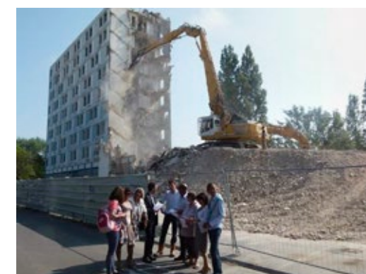
Le foyer de jeunes travailleurs en cours de démolition, Hérouville-Saint-Clair, 2013
