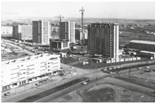
Chantier de la ZUP des Couronneries sur les plateaux de Poitiers, avec la construction du foyer de jeunes travailleurs Kennedy, tour emblématique du quartier, circa 1970
